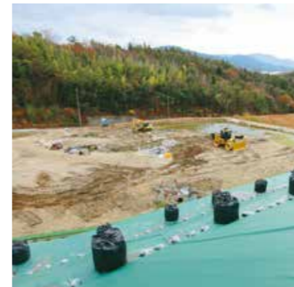
環境センター（沖美町岡大王）にある第2埋立地
