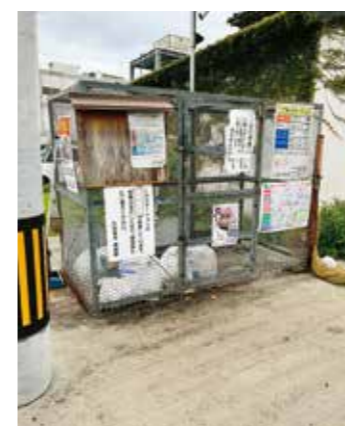
監視カメラの設置による不法投棄抑止の効果を確認
