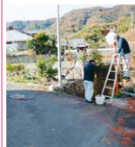
多種多様なインフラ施設を日々点検している
