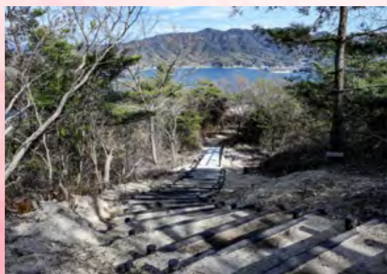
▲観光施設修繕・工事
