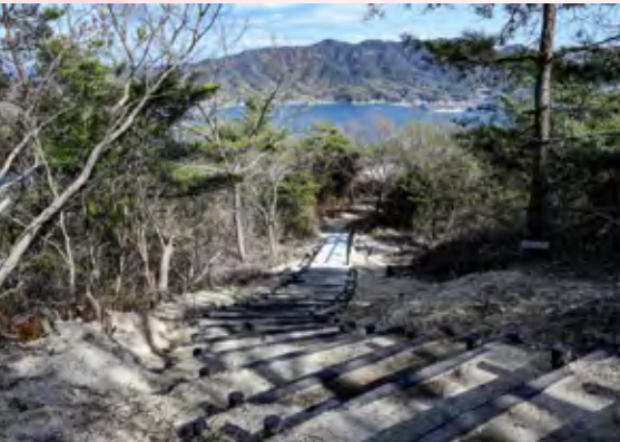
▲観光施設修繕・工事
