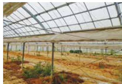
補修される研修用ハウス
