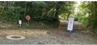
林道入野線にある防火水槽
