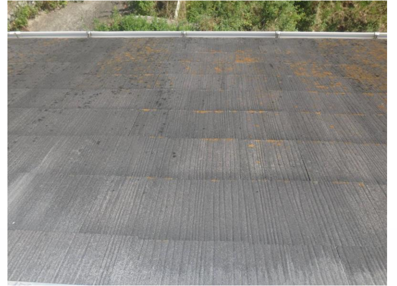
屋根外壁が劣化, 洗浄塗装が必要
