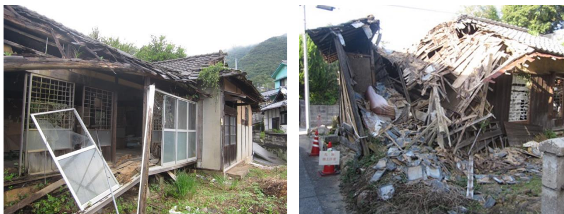
図表 3.3 市の助言に応じ所有者が解体した老朽危険空き家の事例（解体前）
