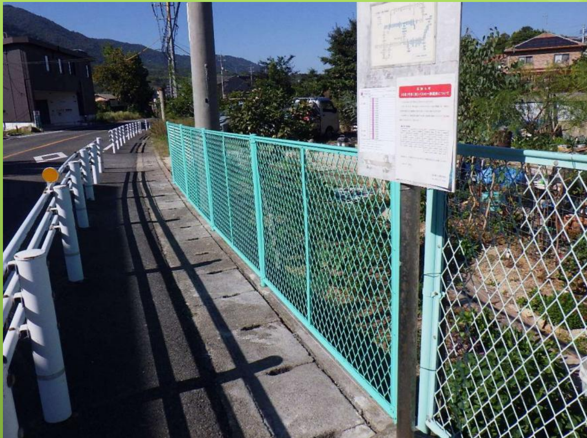
能美町鹿川（大矢橋・中浜バス停付近）国道487号
