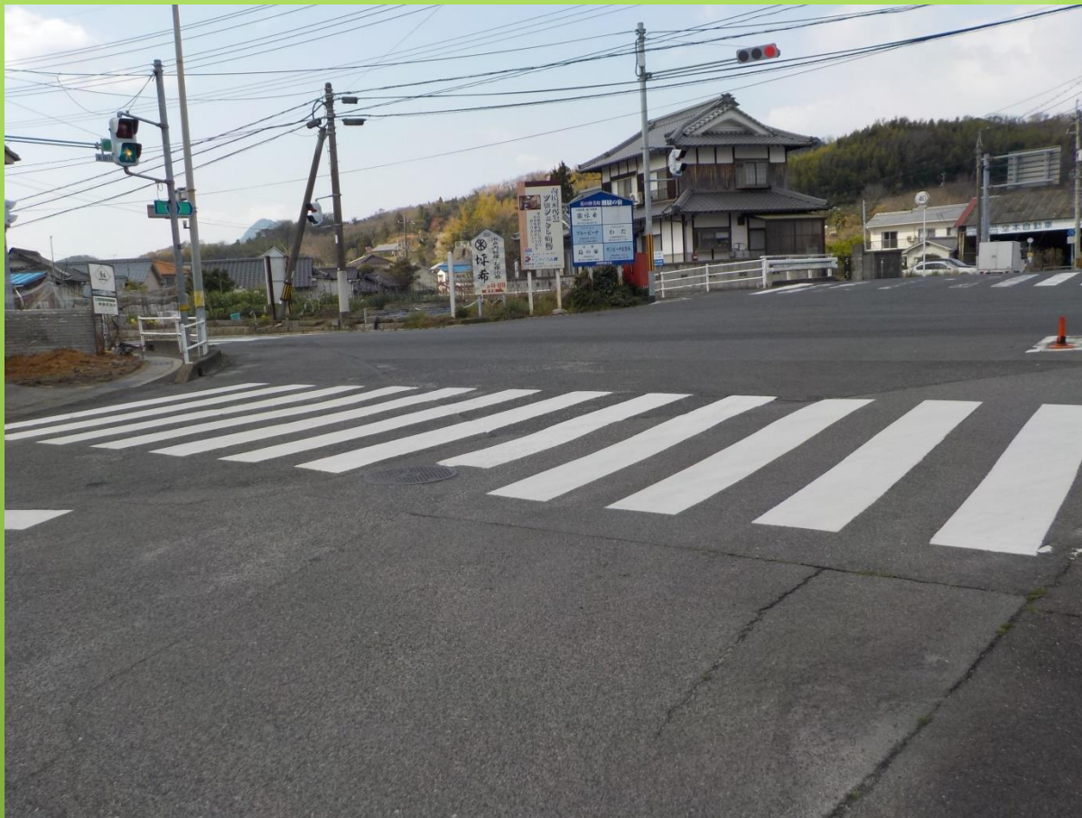
能美町鹿川2739-1番地付近（永田川東詰交差点） 国道487号
