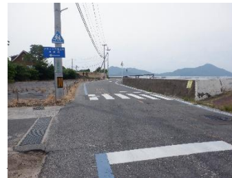
横断歩道の設置 R3対策済み
