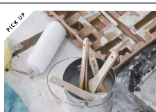
一部はDIY！体験の場を改装中
