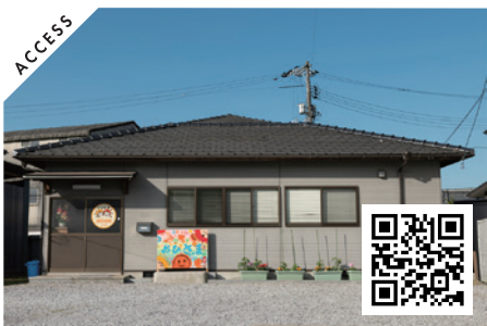
おひさま 2 号館 広島県江田島市大柿町大原 1 0 9 5 - 2 TEL: 0823-27-7022 FAX: 0823-27-7023 (※おひさま 1 号館は柿浦にあります)
