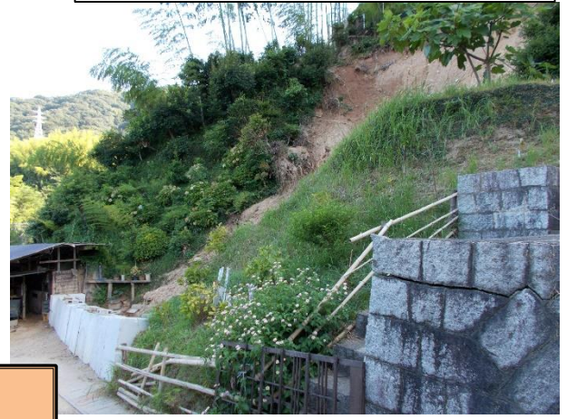
斜面崩壊・被災状況（H30年7月）
