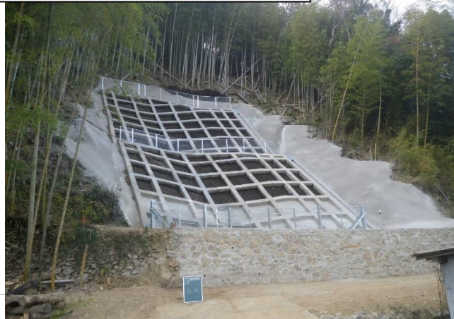
工事完了（令和3年1月25日）
