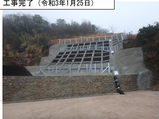
工事完了（令和3年1月25日）
