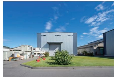
▲令和3年8月に新築されたB工場
