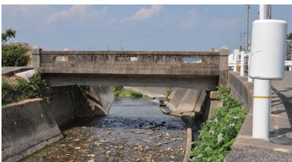
・道路等施設（橋梁）
