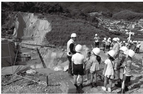
▲工事現場を見学する児童
