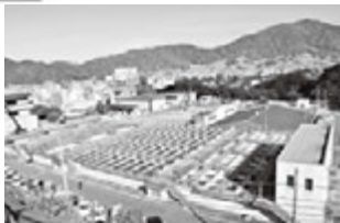
呉市にある宮原浄水場 —(出典：呉市水道 100 年)
