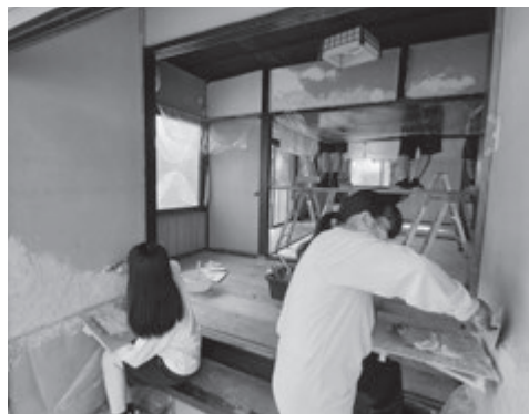
大柿高校生と空き家のリノベーション実習。写真左：外壁塗装 写真右：漆喰塗り
