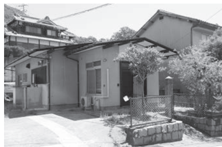
▲令和元年度事業住宅
