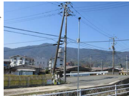
▲新たに設置した監視カメラ
