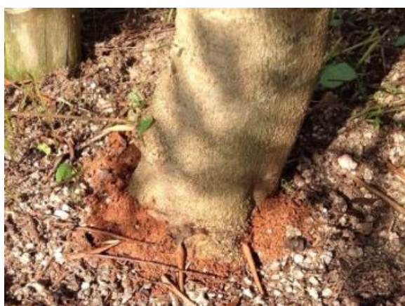
樹の根元に木くずが出ていたら危険信号！
