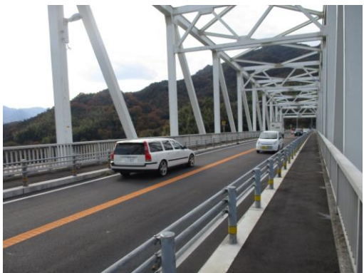
平日状況（江田島方面を望む）
