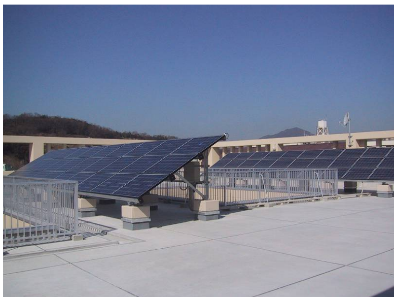
【大古小学校屋上の太陽光発電システム】
